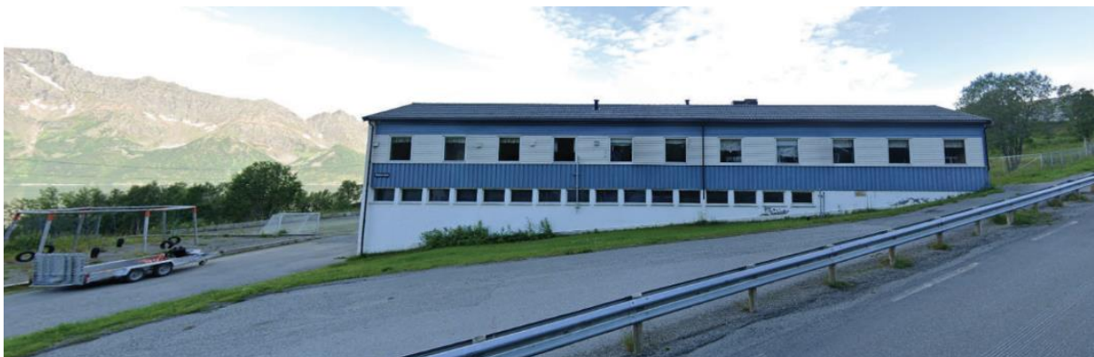
Figur 11: Eksisterende skolebygg nummer 2 (besluttet revet)
