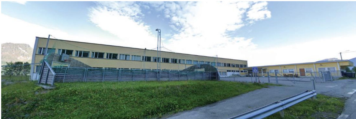
Figur 10: Eksisterende skolebygg nummer 1
