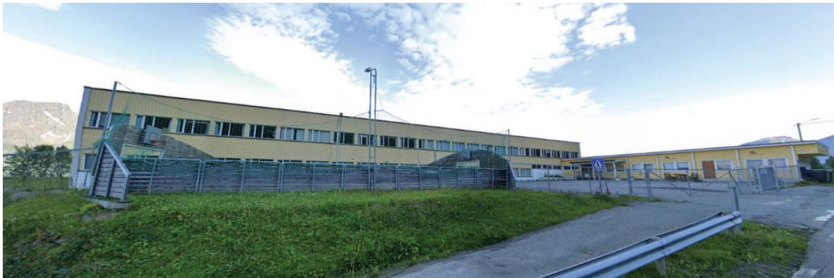
Figur 10: Eksisterende skolebygg nummer 1
