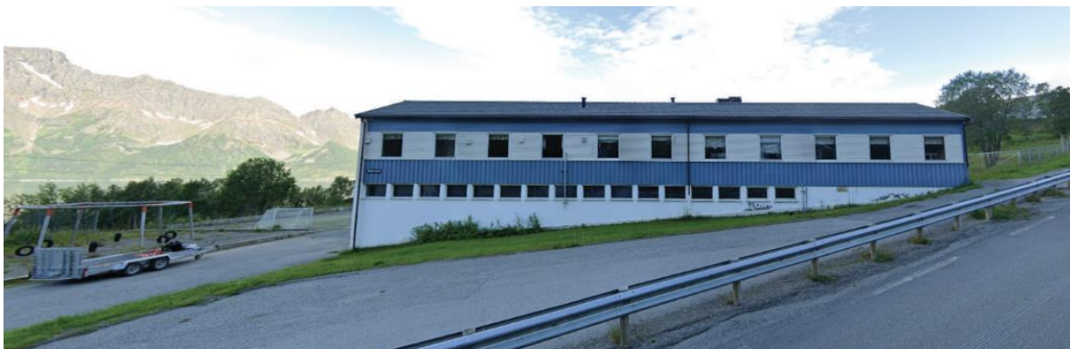
Figur 11: Eksisterende skolebygg nummer 2 (besluttet revet)
