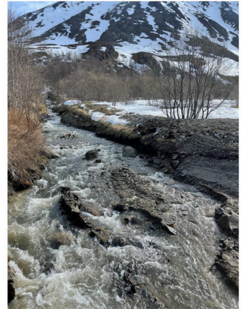
Eksempel på erosjon ved elvekrysset der hovedvannledningen til Øksfjord går under bekken etter flom 26.05.25
