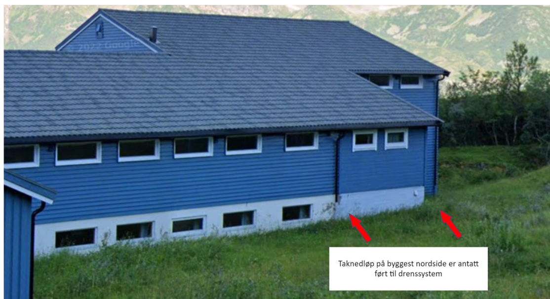
Figur 12. Utsnitt fra google street view, som viser utvendige taknedløp på byggets nordside. Taknedløpene er sannsynligvis tilkoblet drens-systemet.
