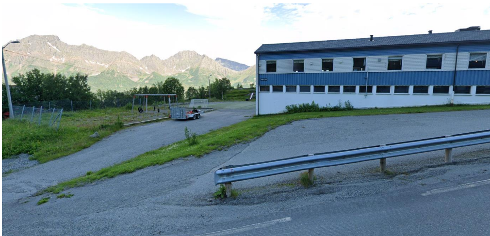
Figur 8: Utklipp fra google street view, som viser dagens situasjon med skole og skolegård.
