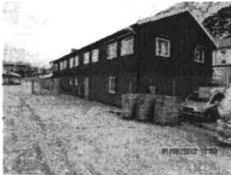
Småbedriftssenteret sett fra syd på kai.
