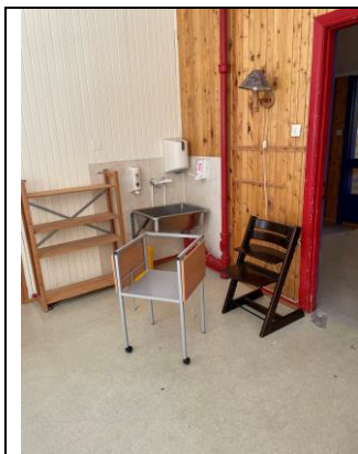
Bilde 34. Vinylbelegg på vegg (og gulv) i 2. etasje av tilbygget håndteres som farlig avfall med ftalater
