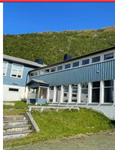
Bilde 58. Pipe nr 2 på eldste del (t.v.) og pipe tilknyttet tilbygget (t.h.)
