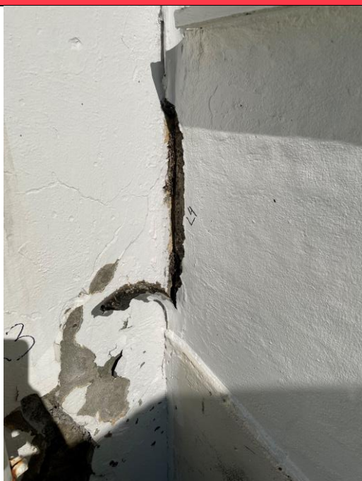
Bilde 20 og Bilde 21. Svart fugemasse mellom eldre del og tilbygg må håndteres som farlig avfall med PCB (prøve L4)
