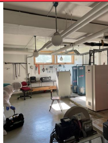
Bilde 5. Rørbend med asbest forekommer også i fyrrommet
