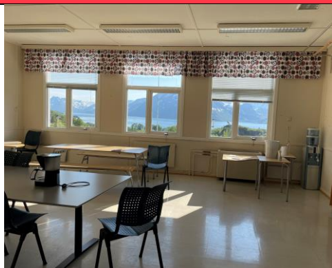
Bilde 22, Bilde 23 og Bilde 24. Vinylbelegg i gang, trapp og klasserom i eldre del inneholder ftalater over grenseverdi for farlig avfall (prøve L12)
