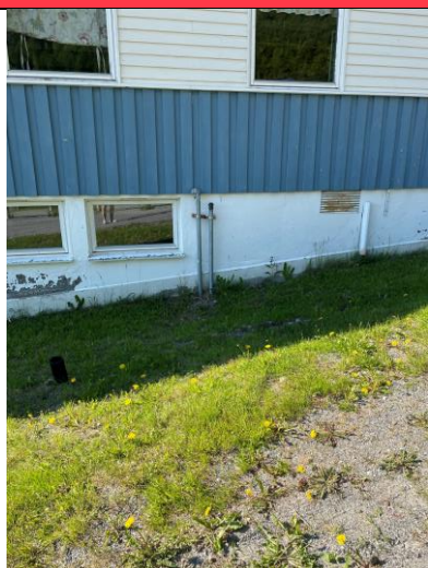
Bilde 54. Påfyllingsrør og lufterør på byggets østside
