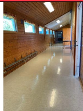
Bilde 22, Bilde 23 og Bilde 24. Vinylbelegg i gang, trapp og klasserom i eldre del inneholder ftalater over grenseverdi for farlig avfall (prøve L12)
