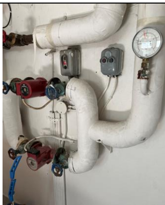
Bilde 8. Endelokk inneholder ikke asbest.
