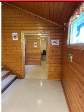
Bilde 22, Bilde 23 og Bilde 24. Vinylbelegg i gang, trapp og klasserom i eldre del inneholder ftalater over grenseverdi for farlig avfall (prøve L12)
