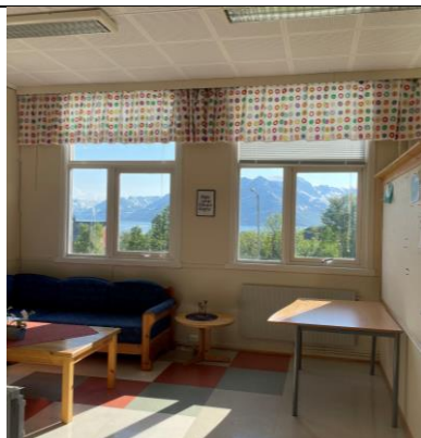
Bilde 9. Lydplater i taket inneholder ikke asbest.
