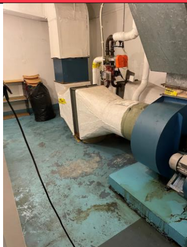
Bilde 3. Asbestanalyser ble foretatt rundt tekniske installasjoner i aggregatrom.
