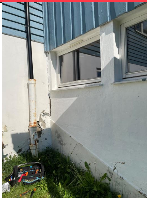
Bilde 20 og Bilde 21. Svart fugemasse mellom eldre del og tilbygg må håndteres som farlig avfall med PCB (prøve L4)
