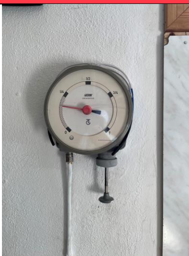
Bilde 55. Nivåmåler viser at det fortsatt er olje på tanken
