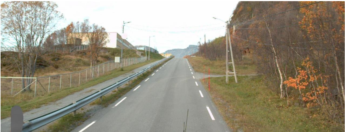
Figur 8 Vegbilde Ystnesveien, adskilt gangveg til Høgtun skole, nordvendt (Kilde Google)
